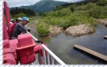
泉田川第1頭首工
