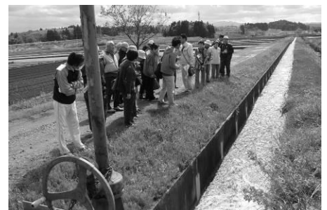
圃場の水路に吐水(角沢地区)
